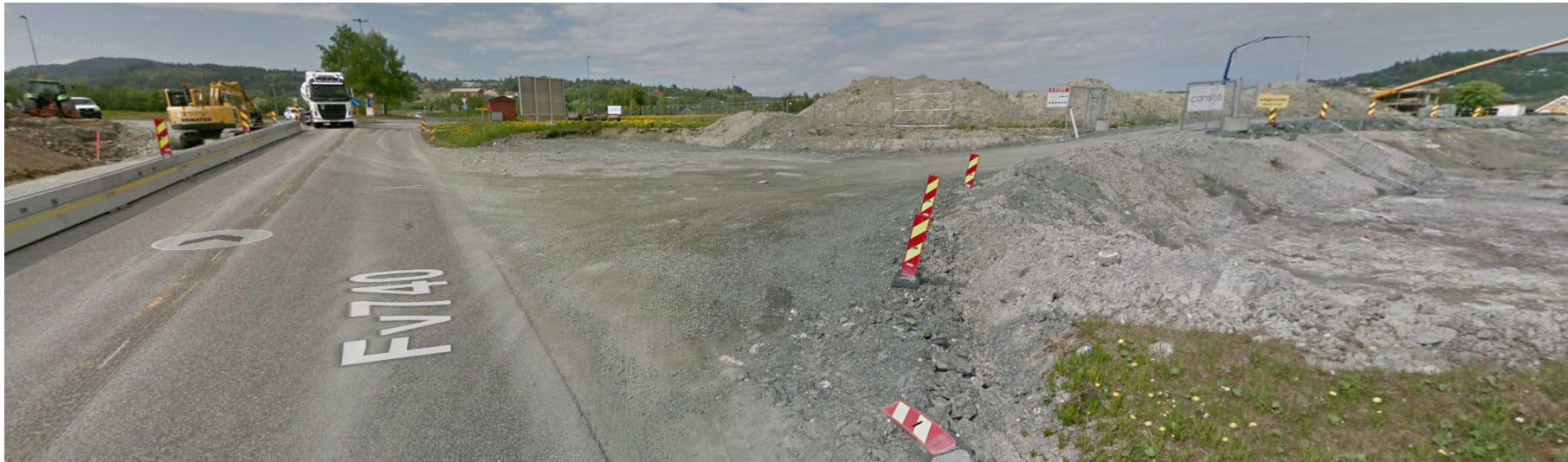
Fig. 5: Dagens avkjørsel under bygging, sett fra nordøst (google streetview)
